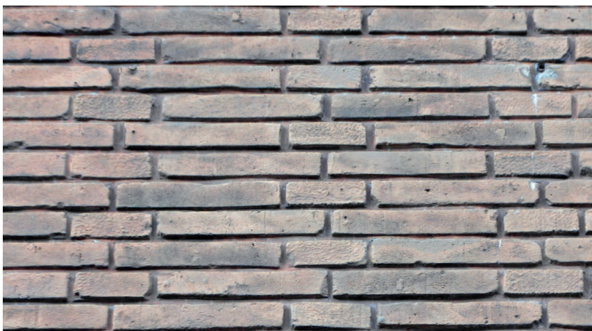
Bij het in de twintigste eeuw geïntroduceerde verdiepte voegwerk komt de baksteen naar voren.
