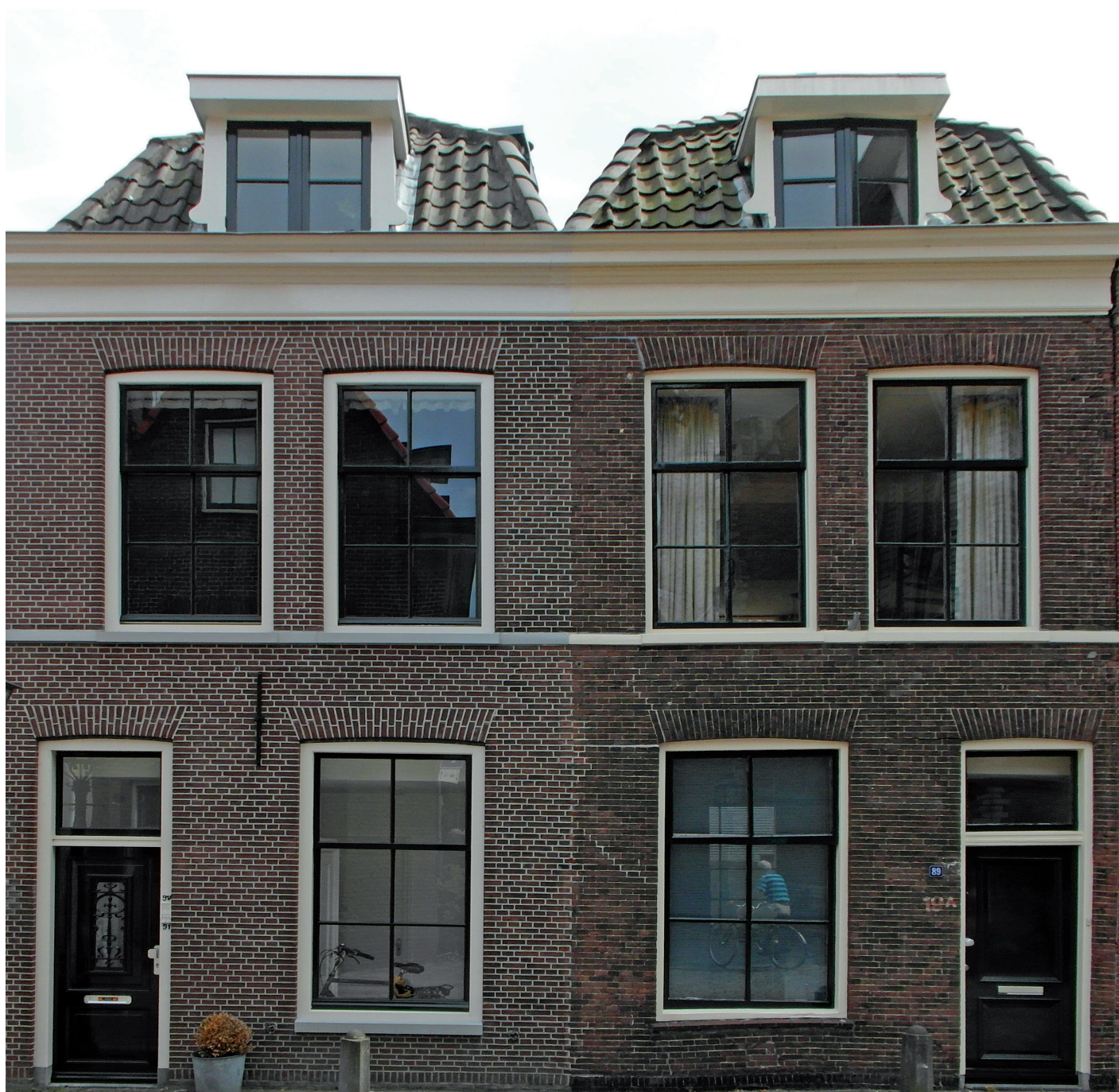
Deze zustergevels met recent (links) en oud (rechts) voegwerk laten zien hoe beeldbepalend de voeg kan zijn.
