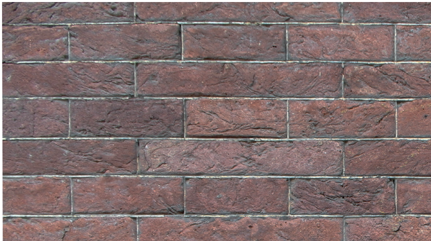
Voor het gewenste gevelbeeld werden voegen vroeger dun uitgevoerd of achterwege gelaten.
